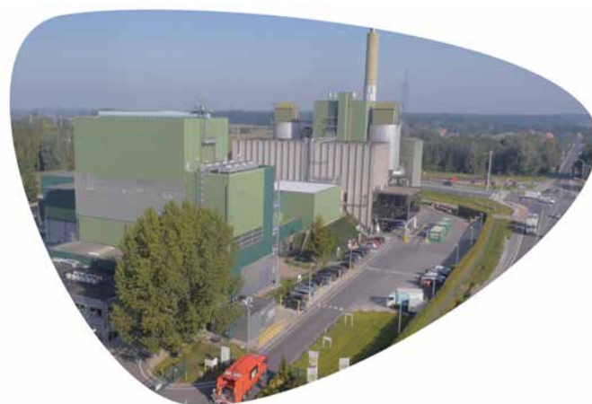
De afvalenergiecentrale van IVM Milieubeheer
